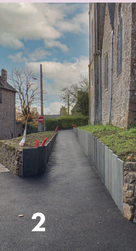
Réalisation d'une rampe d'accès à l'église
